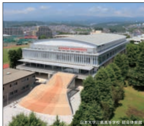
日本大学三島高等学校 総合体育館
